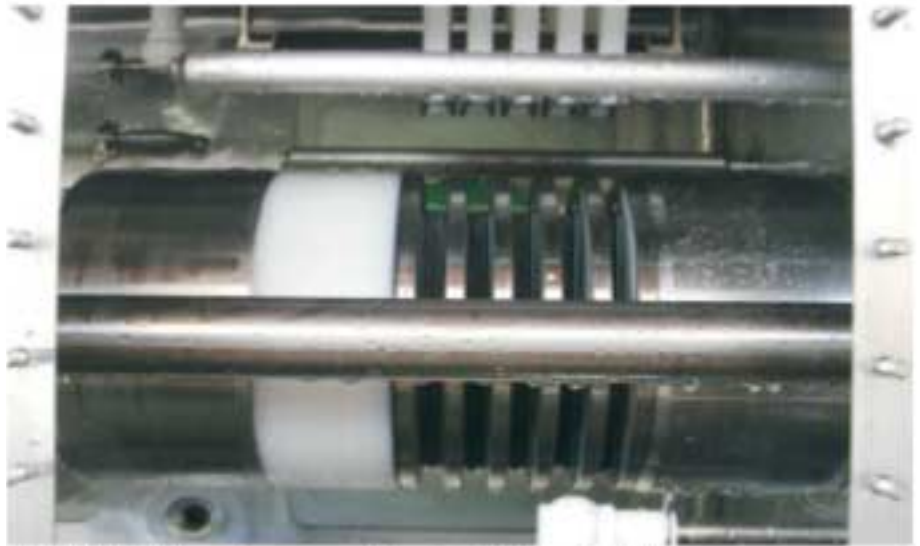
Fig. 9: Vista del área de procesos después de la limpieza CIP.
